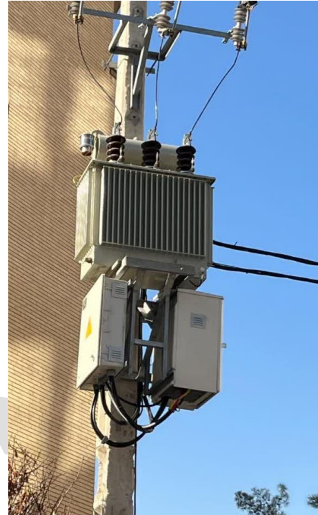
شکل ۱۱- تصاویری از نحوه نصب تابلو مکمل هوایی در کنار تابلو توزیع هوایی موجود
