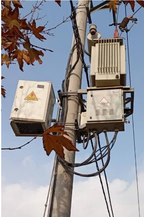
شکل ۱۱- تصاویری از نحوه نصب تابلو مکمل هوایی در کنار تابلو توزیع هوایی موجود
